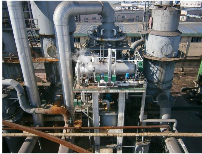
ALPHA Installation at Lvling 绿陵 ALPHA 系统
