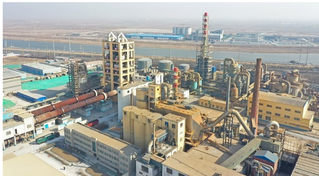
年产30万吨磷铵副产磷石膏制40万吨硫酸联产60万吨水泥装置（简称“30.40.60”）
