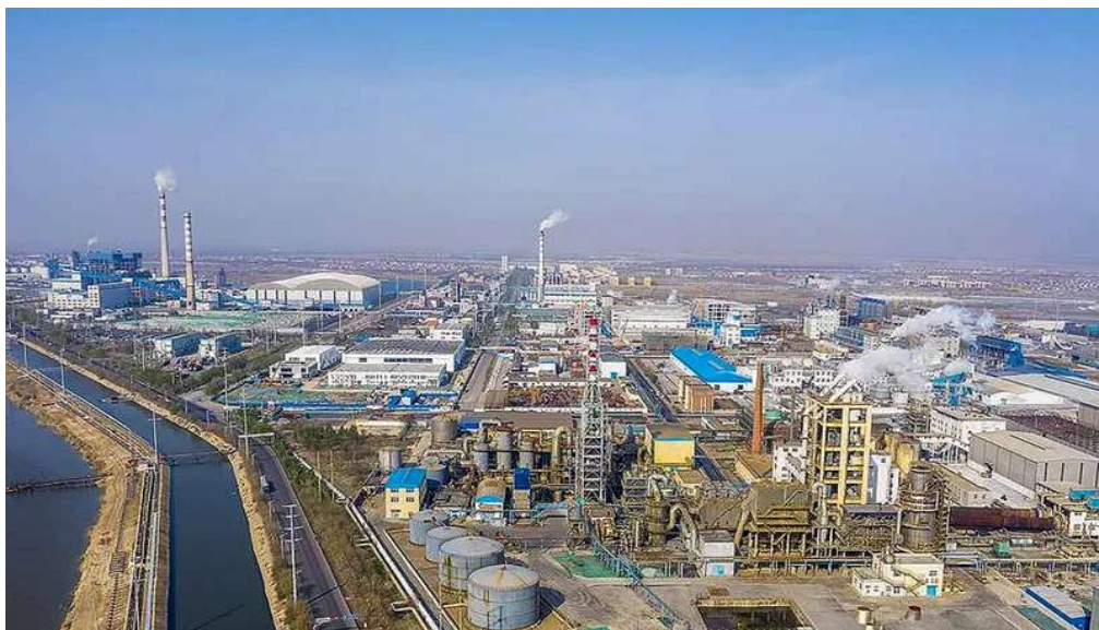
年产30万吨磷铵副产磷石膏制40万吨硫酸联产60万吨水泥装置（简称“30.40.60”）
