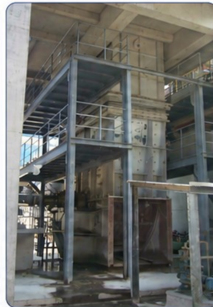
现场安装施工
