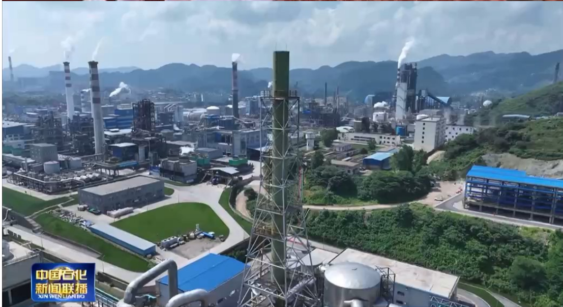
南京工程承建贵州“1468”项目成功投产
