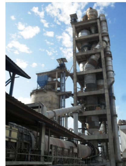
老挝1500t/d改2000t/d工程
